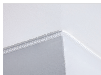
Verlegung des Clear Track-Glasfaserkanals Hallway um eine Außenecke
