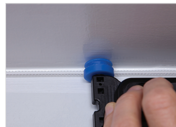
Installation des Clear Track Innenkabel im Clear Track-Glasfaserkanal Hallway
